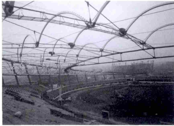
图2 体育场施工进度
